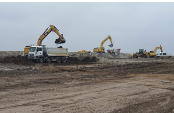
Recuperación de los residuos de hormigón para su reutilización.
