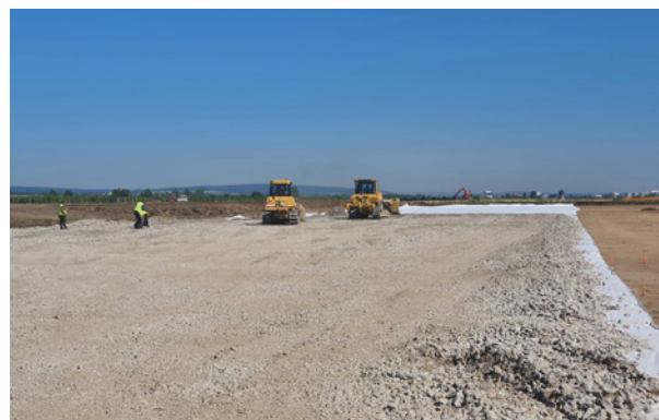
Reutilización de los residuos en la nueva pista y calles de rodaje una vez triturados.
