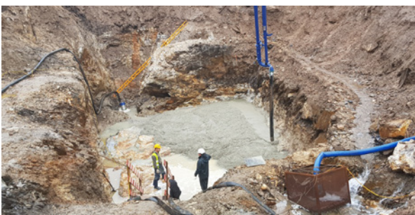
Detalle de la recirculación del agua hacia las balsas de decantación y los tanques para el control de su pH.
