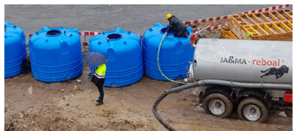
Camión cisterna dispuesto en obra para poder llevar, en caso necesario, el agua contaminada al sistema de tratamiento existente en otra obra próxima.
