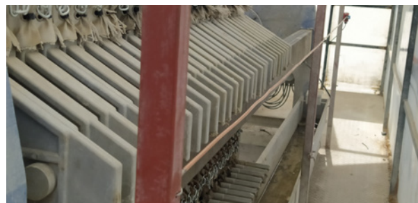
Detalle del interior del filtro de prensa. La nube de fangos que permanece en estado de suspensión concentrada consigue la floculación acelerada. El agua que pasa el filtrado por el lecho de fangos se recoge totalmente libre de sólidos.
