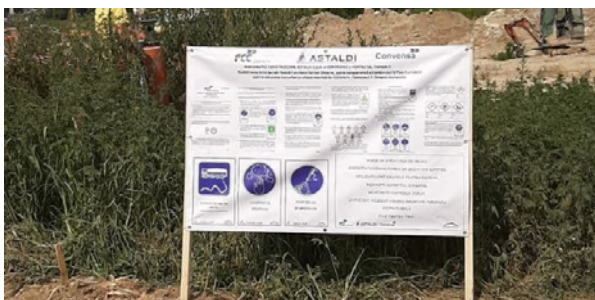
Señalización instalada en obra para evitar la generación de emisiones de partículas de polvo a la atmósfera.
