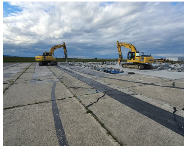
Demolición de la pista del aeropuerto de Bacau.
