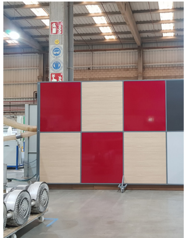
Paneles acústicos instalados para atenuar las emisiones acústicas en las áreas aledañas al uso de la fresadora.
