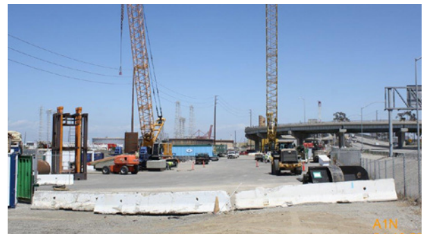
Vista del taladro empleado en la perforación del pozo. En el pozo se aplicó un revestimiento temporal para evitar la difusión del agua contaminada con benceno de las capas más profundas hacia las capas más superficiales del subsuelo.
