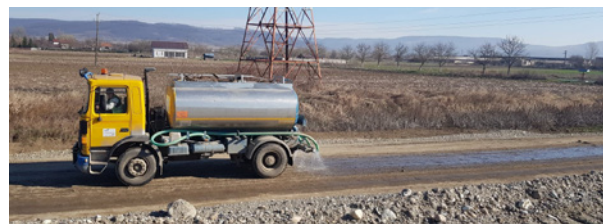
Riego de caminos para reducir las emisiones de polvo producidas por la circulación de vehículos durante el transporte de materiales o personas.
