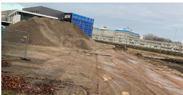
Acopio de material tras ser machacado para su posterior reutilización.
