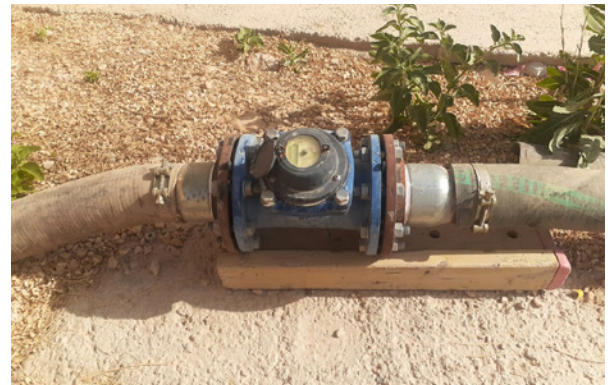
Contador de agua instalado por el municipio de Riad para controlar la cantidad de agua utilizada.
