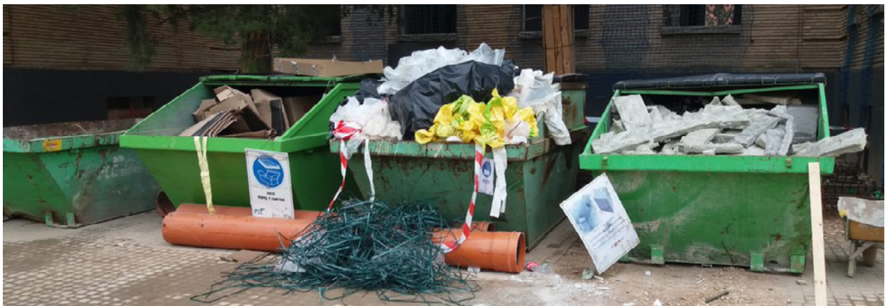
Distribución de contenedores para poder llevar a cabo una correcta segregación de residuos en las obras de remodelación de la Universidad de Zaragoza.
