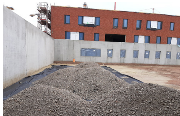
Zahorras dispuestas para ser extendidas en el patio exterior de la prisión.
