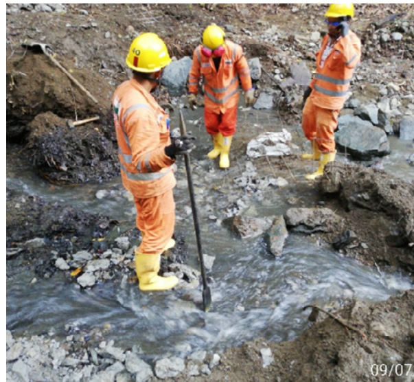
Detalle de los trabajos de demolición de las estructuras en el lecho del río.
