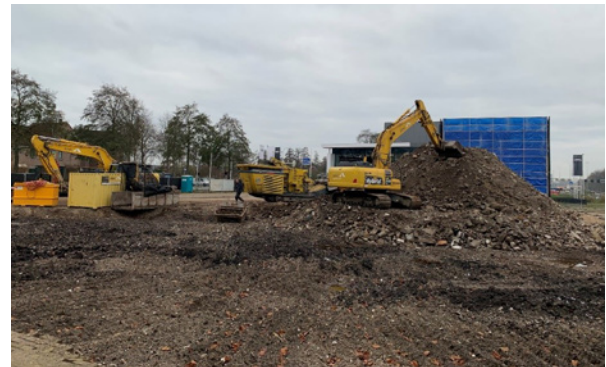
Acopio del material e inicio de la fase de trituración.
