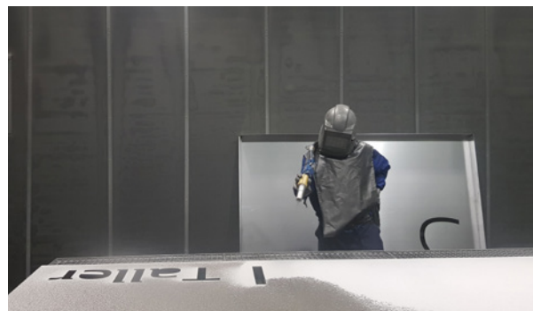
Megaplas. Vista de los trabajos realizados de pintura y lijado de superficies.
