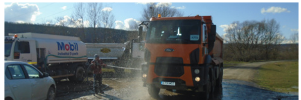
Limpieza de camiones en la salida de la obra para reducir las emisiones de polvo en el entorno del proyecto.
