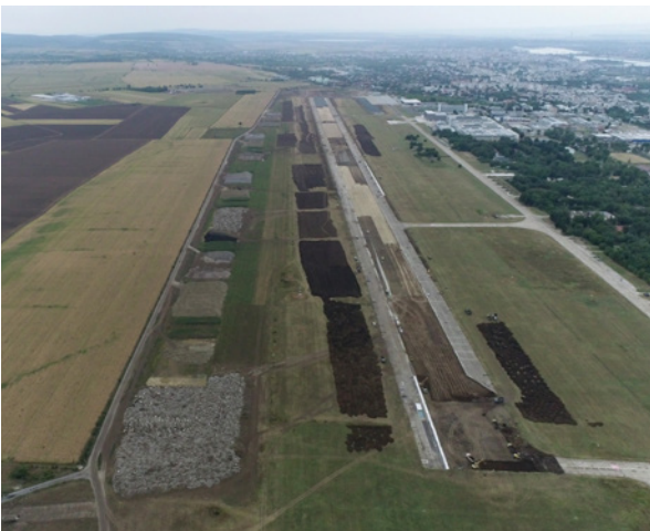
Detalle de la pista del aeropuerto de "George Enescu" de Bacau.
