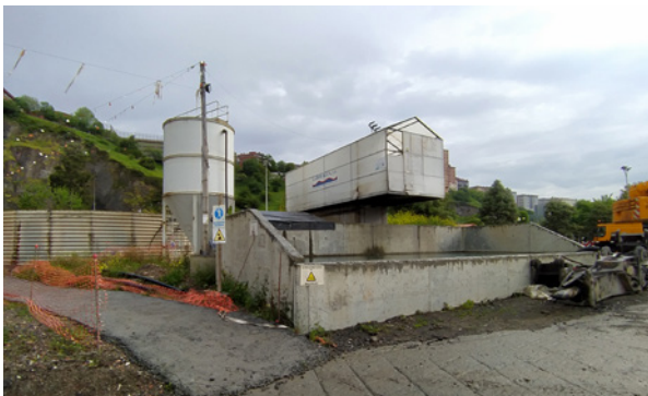
Vista del decantador, filtro prensa y depósito de agua tratada. Tanto los procesos de coagulación y floculación, como los de decantación y clarificación, permiten la eliminación de los sólidos en suspensión disueltos en las aguas. Posteriormente se lleva a cabo el ajuste del pH, previo al vertido.
