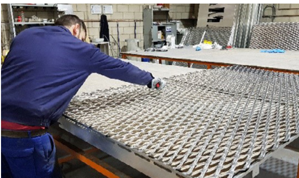
Megaplas. Vista de los trabajos realizados de pintura y lijado de superficies.
