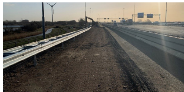
Extensión del material reciclado en la A9.
