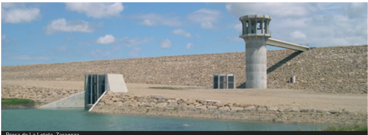
Presas de La Loteta, Zaragoza
