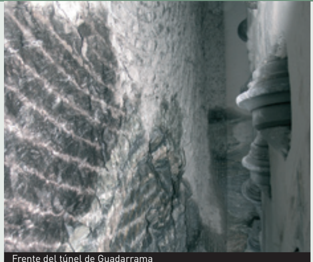
Frente del túnel de Guadarrama
