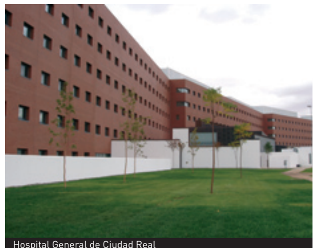
Hospital General de Ciudad Real
