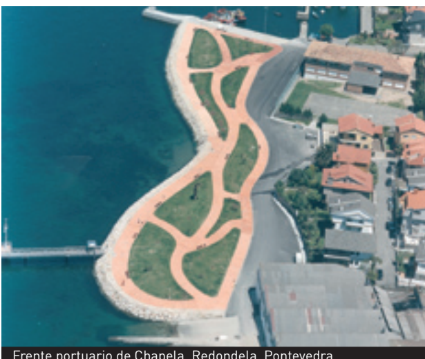
Frente portuario de Chapela. Redondela, Pontevedra
