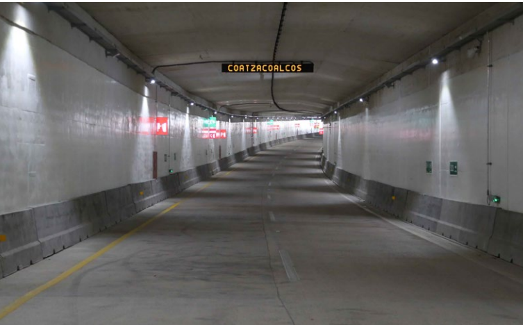
Túnel sumergido de Coatzacoalcos (México).
