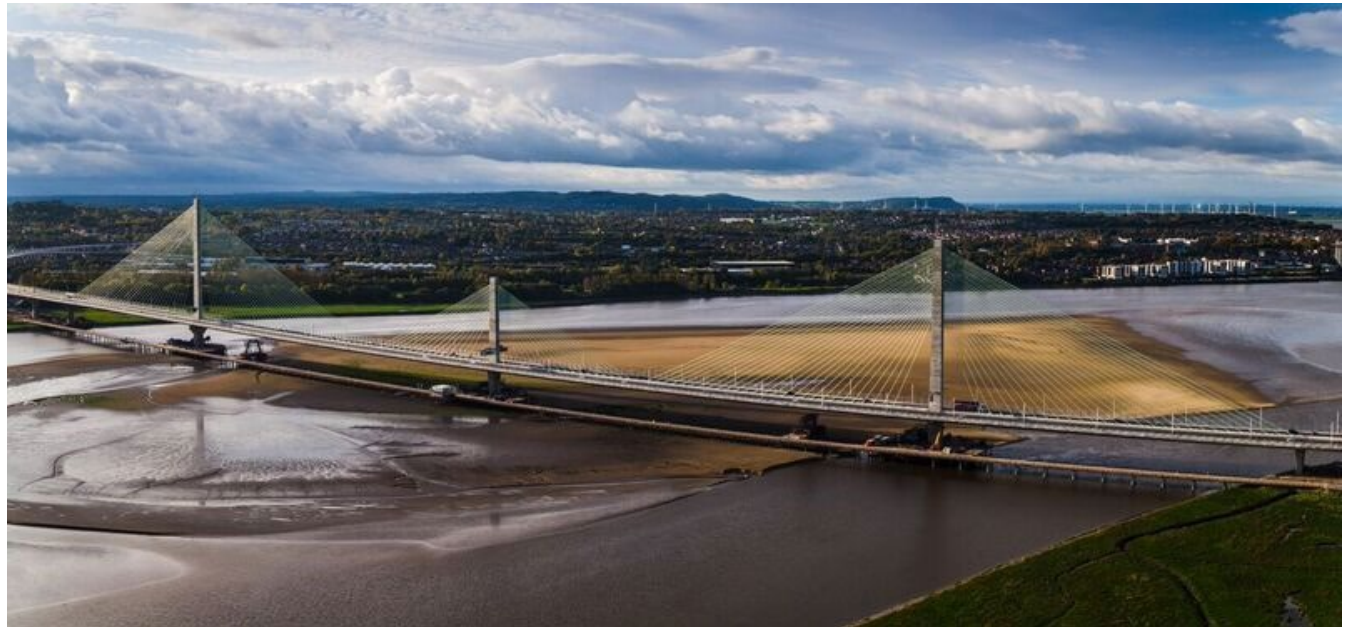
Mersey Gateway Project (Reino Unido).
