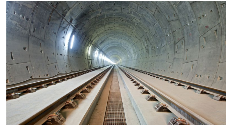
Metro de Riad. Líneas 4, 5 y 6 (Arabia Saudí).
