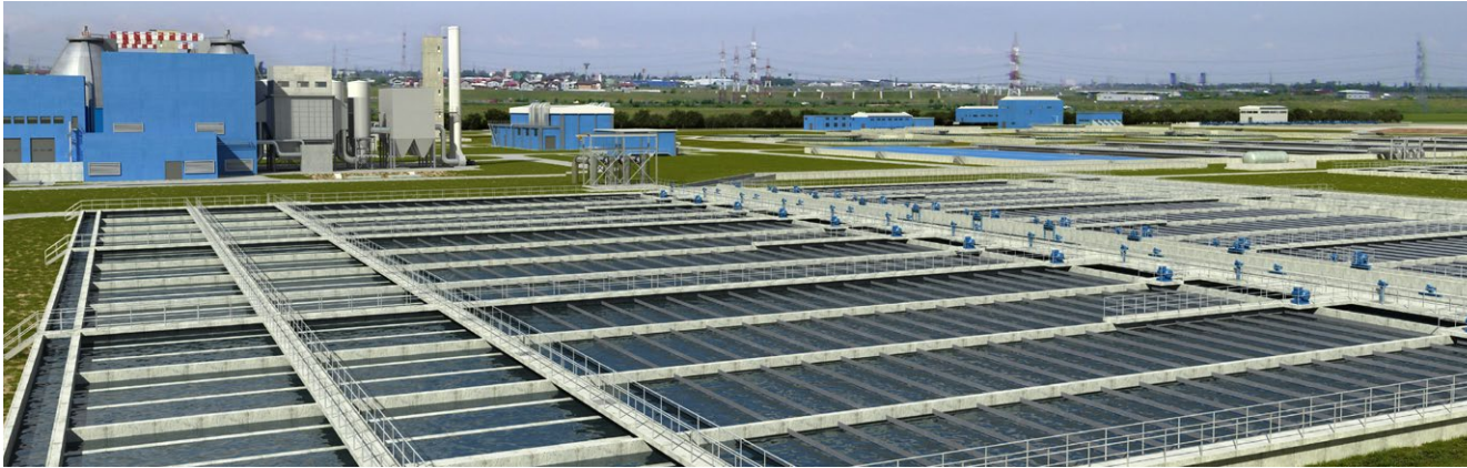
Depuradora de aguas residuales de Glina, en Bucarest (Rumanía).
