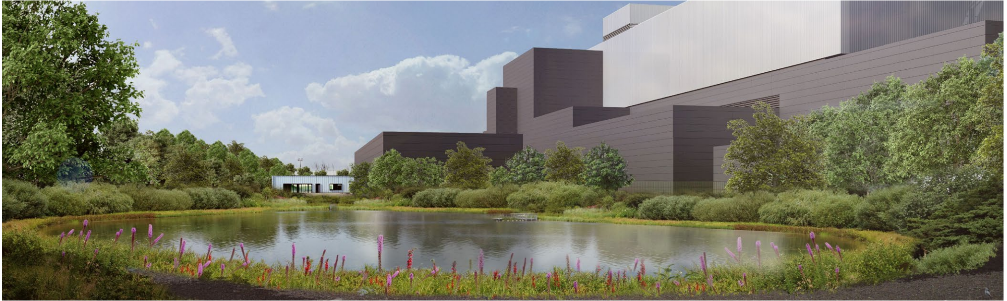
Planta de reciclaje y valorización energética de residuos en Millerhill (Midlothian, Edimburgo).
