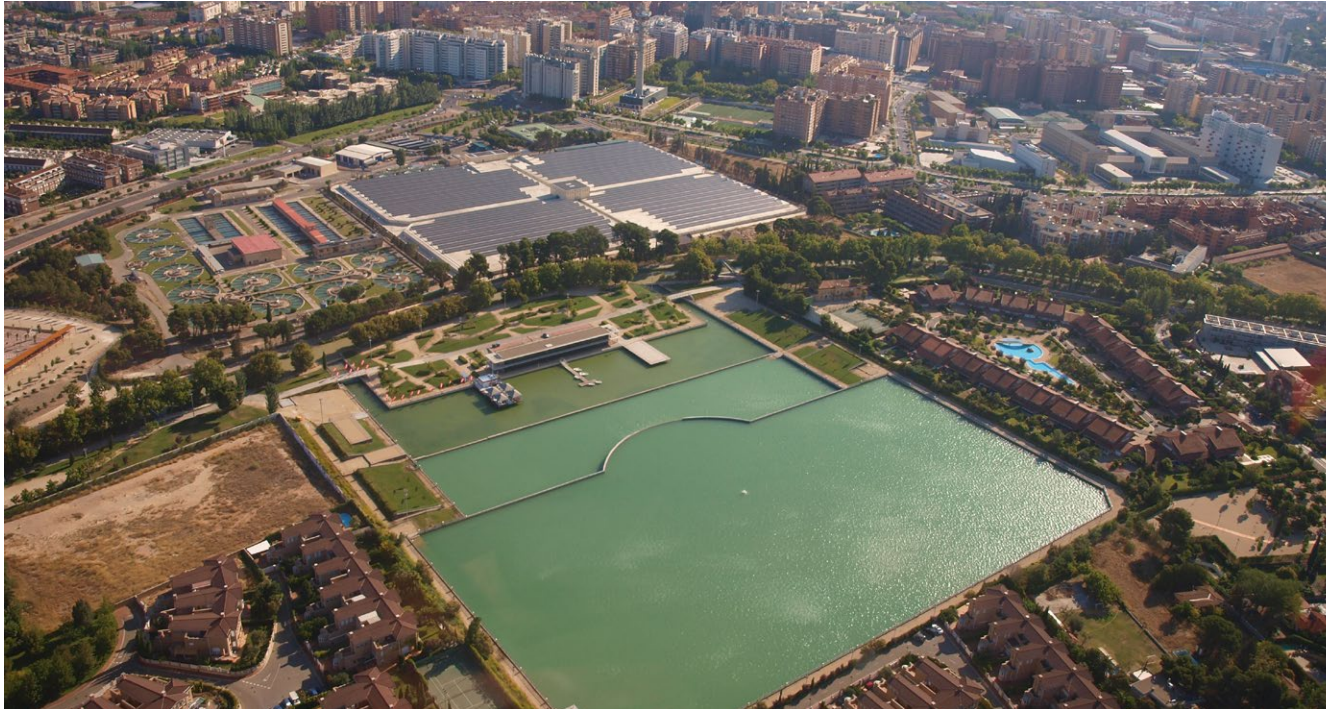
Depósitos de agua de Casablanca, Zaragoza. España
