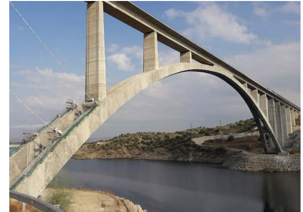
Viaducto de Almonte, Cáceres (España).
