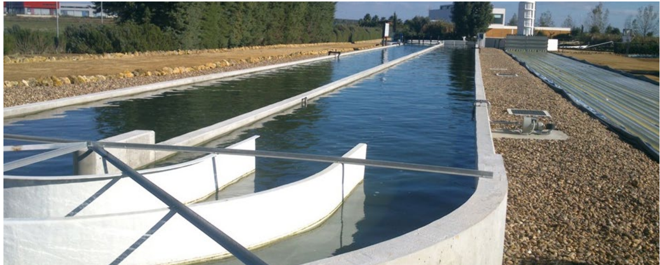
Raceways para el cultivo de microalgas.
