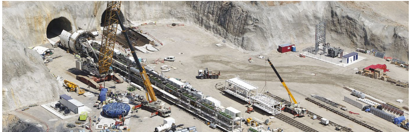
Túnel de Pajares (España)
