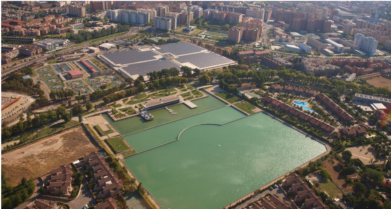
Depósitos de agua de Casablanca, Zaragoza. España
