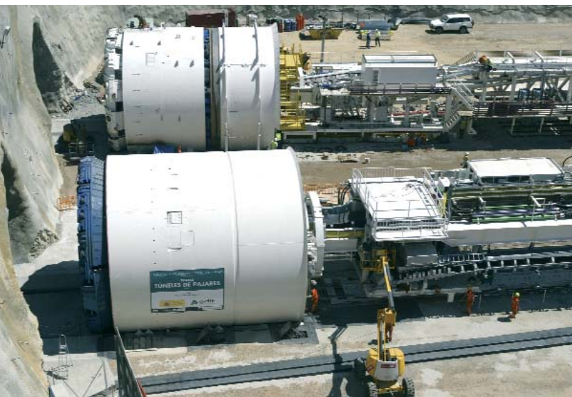
Túnel de Pajares. Pola de Gordón-Folledo en la nueva línea de alta velocidad León-Gijón
