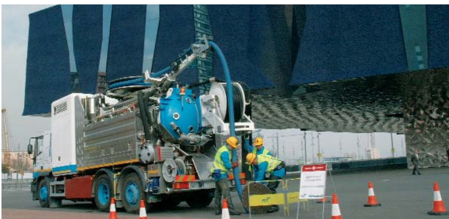
Limpieza de alcantarillado con vehículos mixtos de aspiración y propulsión
