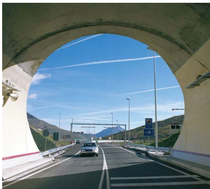
Concesión del túnel del Sóller. Palma de Mallorca
