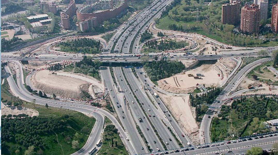
Remodelación del enlace M-23-O'Donnell y la M-30. Madrid
