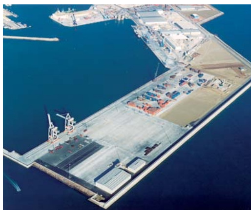
Terminal de graneles sólidos y dársena sur del puerto de Castellón
