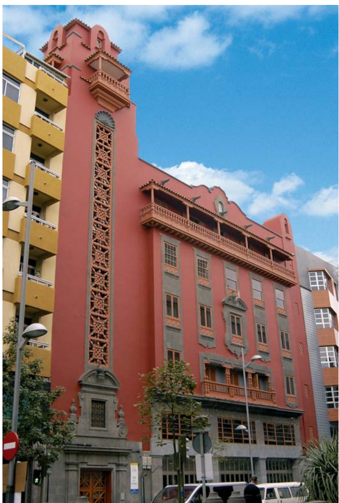
Edificio El Frontón en Las Palmas de Gran Canaria
