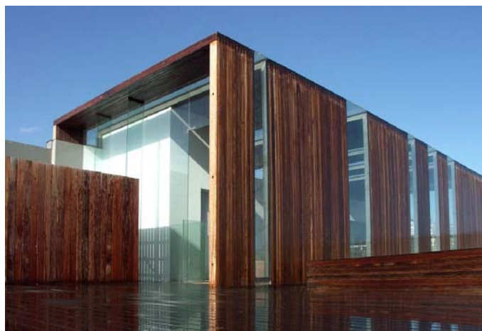
Rehabilitación de casas consistoriales de Las Palmas de Gran Canaria
