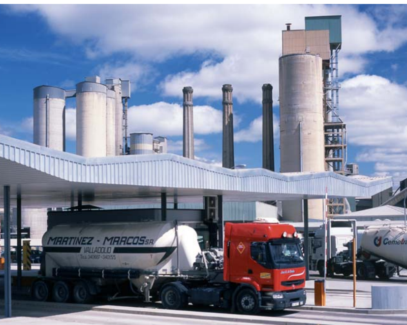
Fábrica de cemento en Hontoria. Palencia
