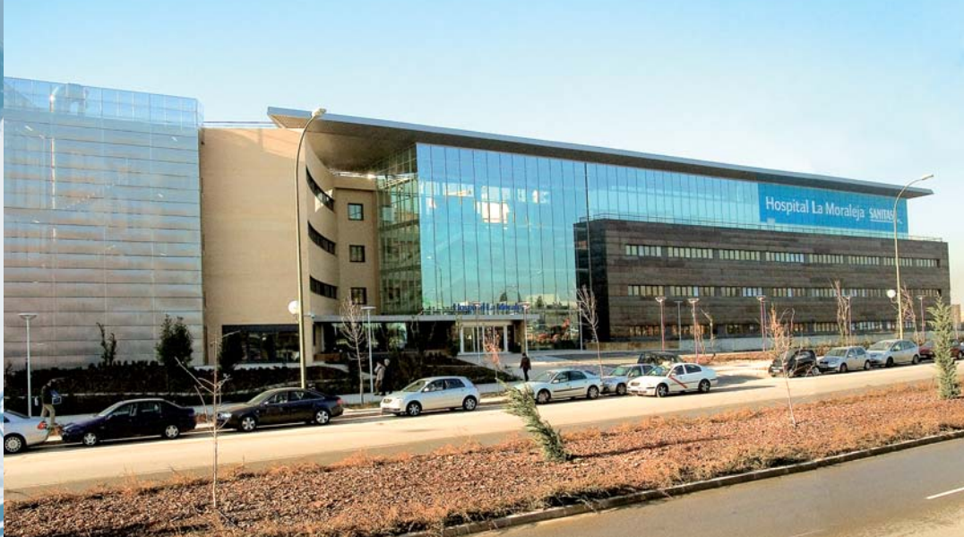
Hospital de Sanitas en Sanchinarro. Madrid
