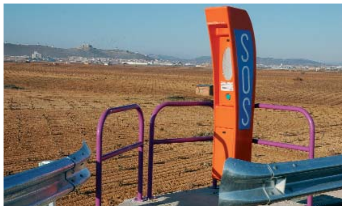
Conservación de la autovía Los Viñedos. Castilla-La Mancha
