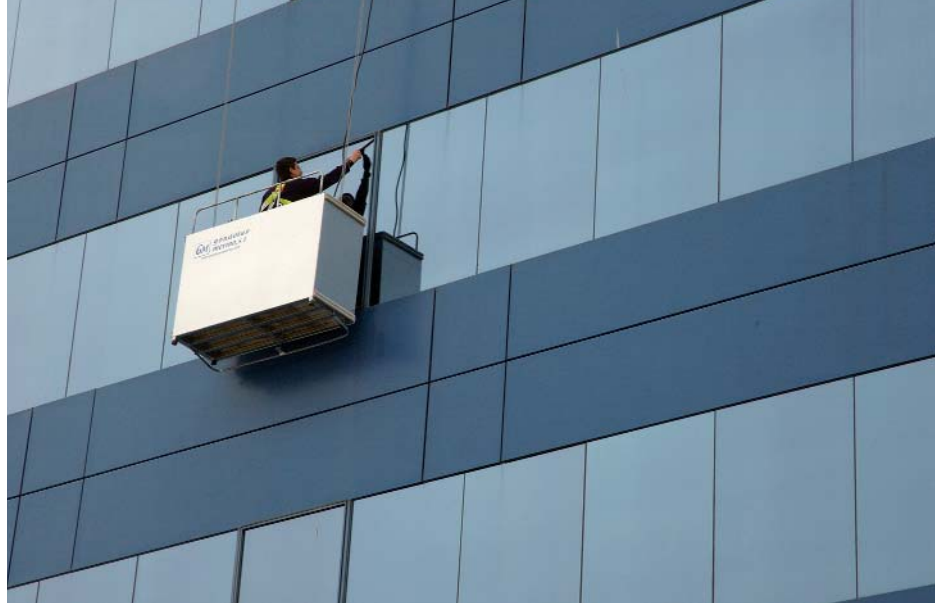
Mantenimiento y limpieza del edificio del BOE. Madrid
