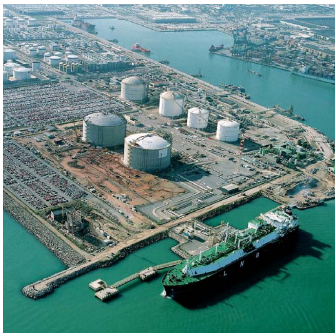
Quinto tanque de almacenamiento de gas natural licuado en el puerto de Barcelona
