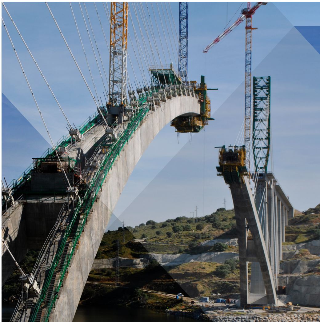
Puente Ingeniero Gilberto Borja Navarrete - Viaducto de San Marcos (México).
