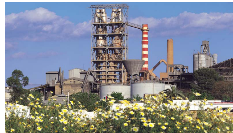
Fábrica de Alcalá de Guadaíra, Sevilla (España).
