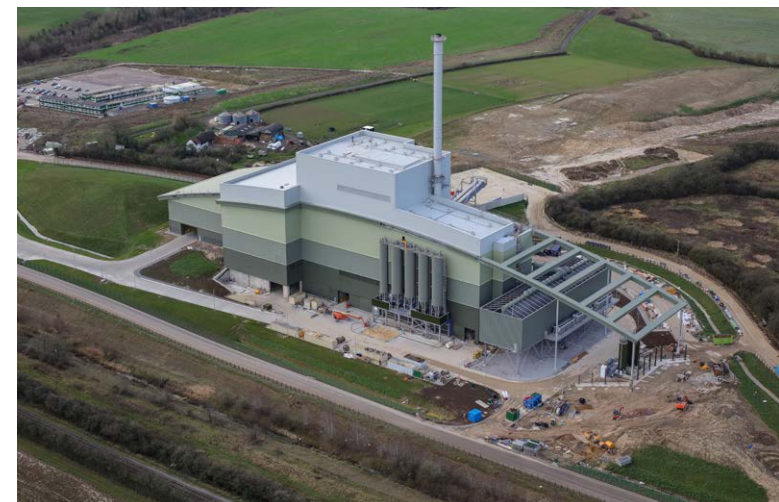
Planta incineradora de Buckinghamshire (Reino Unido).
