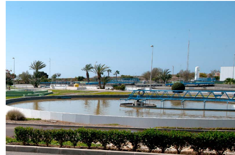
Estación depuradora de aguas residuales de Almería (España).
