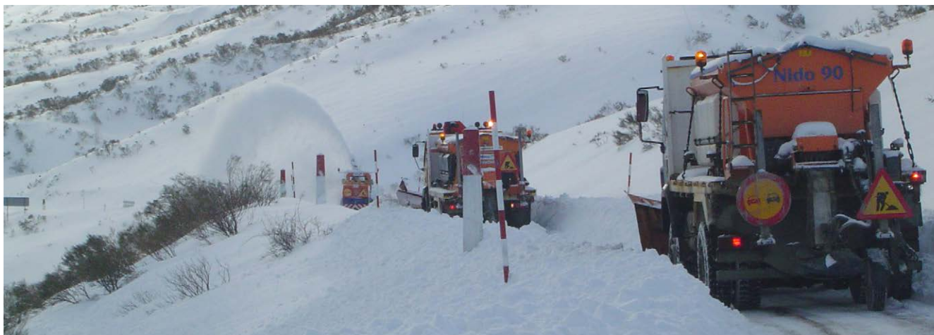
Trabajos de conservación y mantenimiento.
