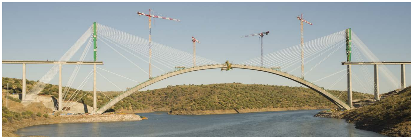
Viaducto de Almonte (España).
